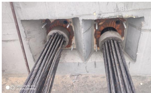
Рисунок 5. “Post tension” – дальнейшее натяжение
