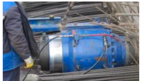
Рисунок 5. “Post tension” – дальнейшее натяжение
