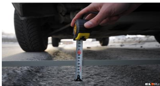
6-Расм. Асфальтбетон қопламаларининг деформацияси натижасида бузилиш ҳолати.
