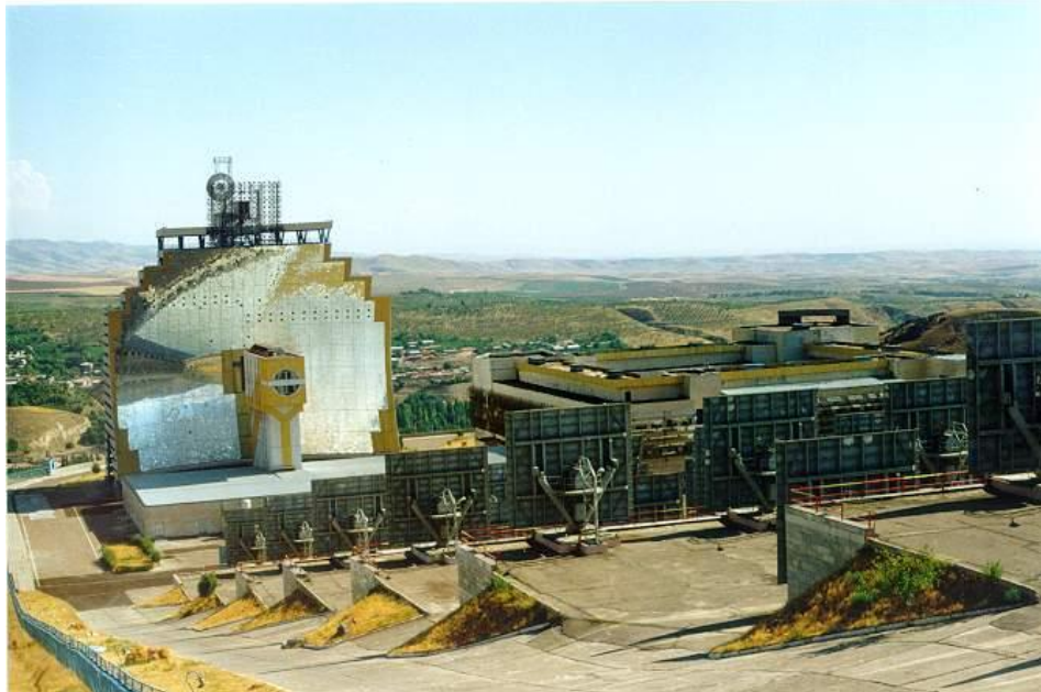
Общий вид уникальной Большой солнечной печи мегаваттной мощности в Паркенте (Узбекистан)
