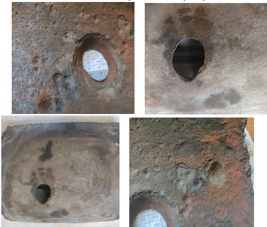
Рис. 1. Фото фрагмента подвергнутого коррозии
